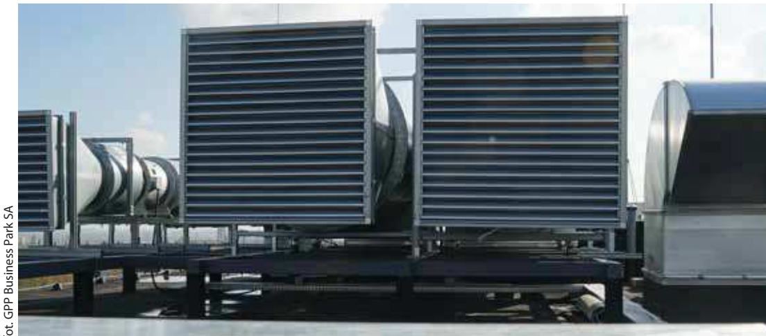
System oddymiający garażu podziemnego
